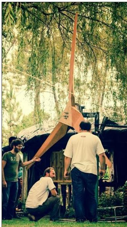
Venez participer à la construction et à l'installation d'une éolienne Piggott et faites un pas vers l'autonomie. Profitez d'une semaine pour acquérir un savoir-faire utile et être solidaire. Pendant cette semaine, nous fabriquerons une éolienne de 4m20 de diamètre conçu pour être raccordée au réseau.
