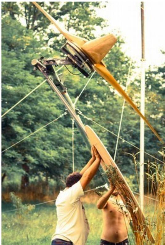
Venez participer à la construction d'une éolienne Piggott et faites un pas vers l'autonomie. Profitez du week-end pour acquérir des savoir-faire utiles. Pendant ce week-end, nous fabriquerons une éolienne de 1m80 de diamètre conçue pour fonctionner connectée à une batterie.
