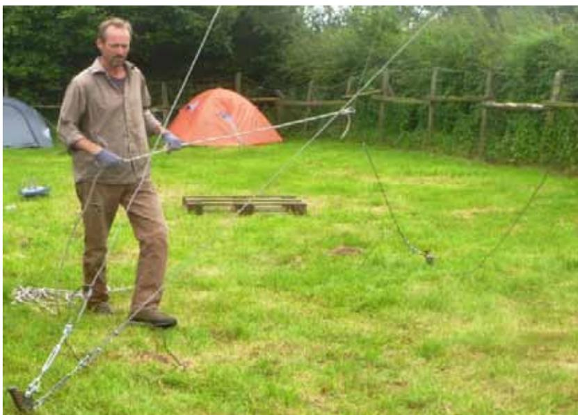
Fig. 12 : Sangle attachée au hauban supérieur (direction de descente du mât)
