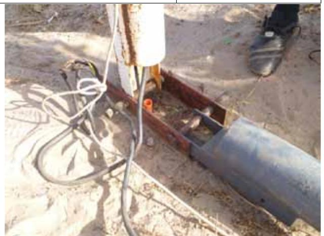
Fig 3 : Sable au niveau du pied de mât
