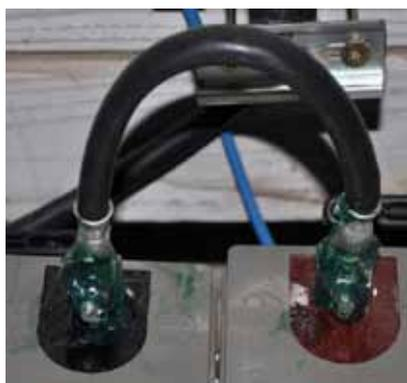
Fig. 57: Connecteur graissé
