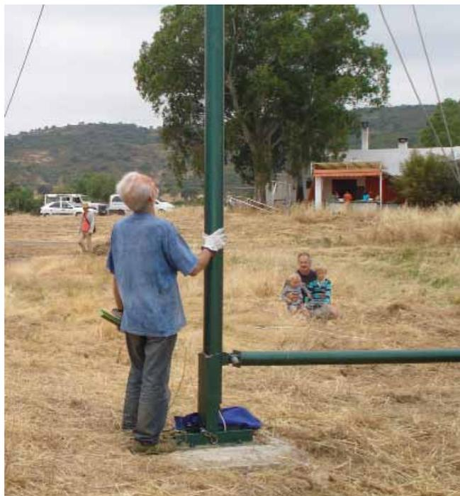
Fig. 25 : Contrôle de la verticalité en haut du mât
