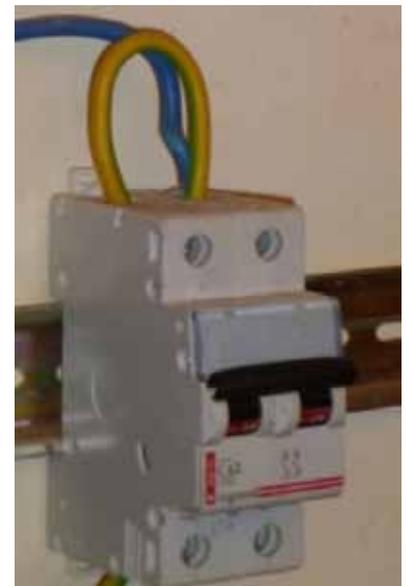
Fig. 8 : interrupteur sectionneur
