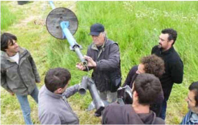
Fig. 19 : Mise en place de la nacelle sur le mât
