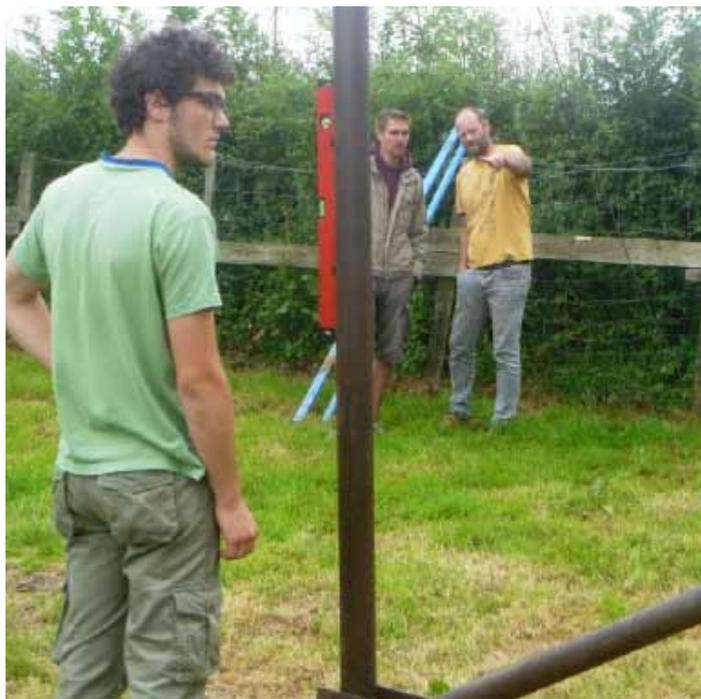
Fig. 24 : Contrôle de la verticalité en bas du mât
