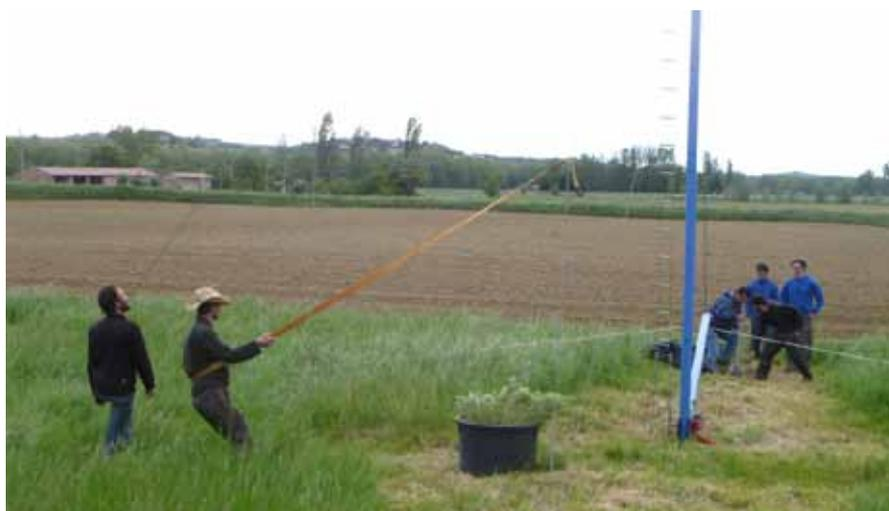
Fig. 14 : Sangle pour tirer sur le hauban supérieur
