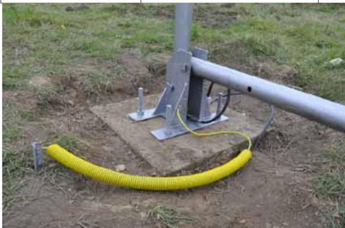
Fig. 2 : Mise à la terre du mât et des électroniques
