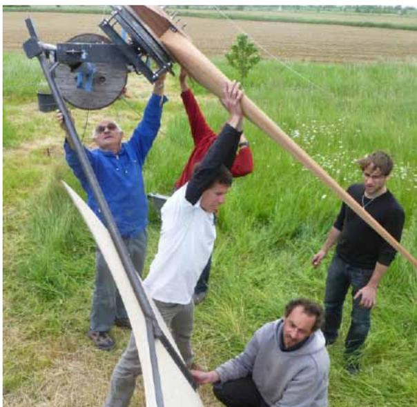
Fig. 22 : Maintient du safran et des pales
