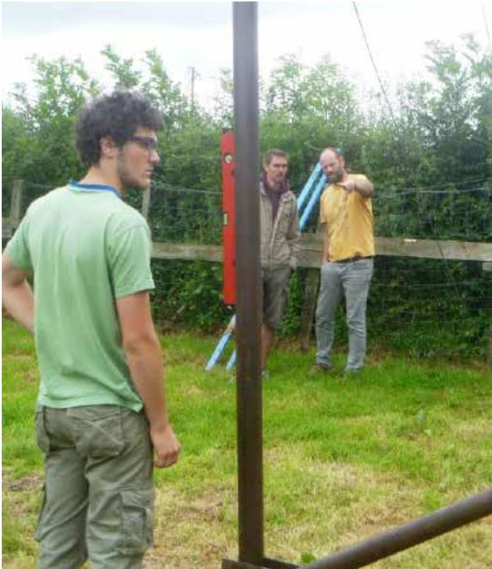
Fig. 24 : Revisión de la verticalidad en la parte inferior de la torre
