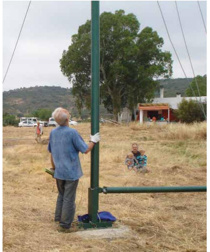
Fig. 25 : Revisión de la verticalidad en las partes superiores de la torre
