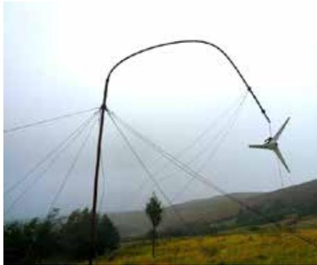
Fig. 57: Broken guy wires
