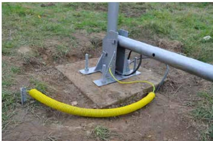
Fig. 2: Conexión de tierra de la torre y los sistemas electronicos.
