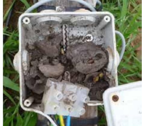
Fig. 47: Habitantes de una caja de conexiones
