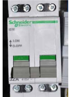
Fig. 1: Interruptor de frenado.
